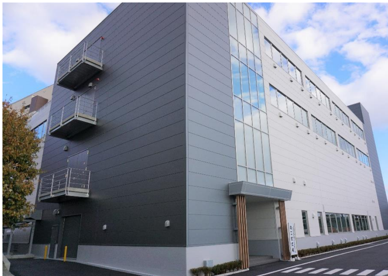
第二研究棟外観
