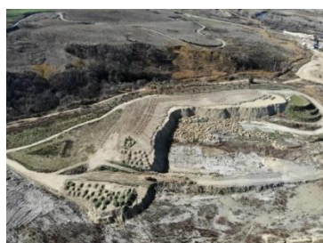
メルフィ採砂場修復のための埋め戻し
