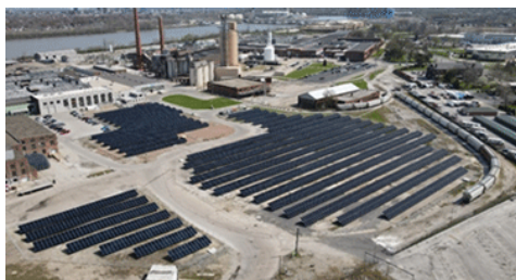
ロスフォード工場における薄膜型ソーラーパネル
