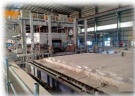
↑ 設備据付工事の状況 (ベトナム)
