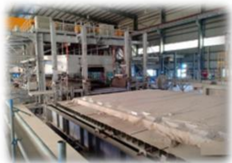
↑ 設備据付工事の状況 (ベトナム)
