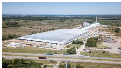
アルゼンチンの新フロートライン（建設中）
