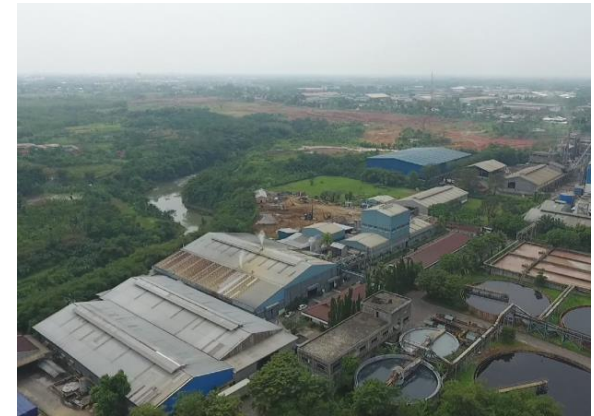
インドネシアJV 新工場予定地
