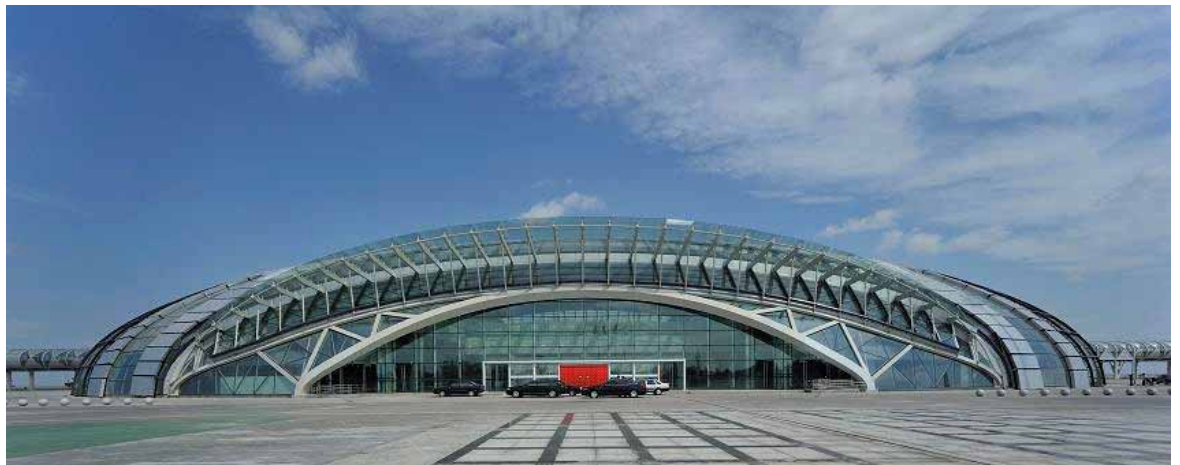
上海国際航運センター呉淞口国際クルーザー港の建物（エネルギーアドバンテージ使用事例）
